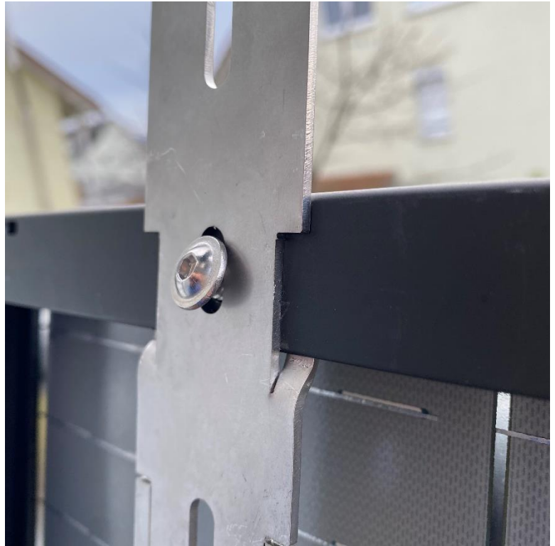
Abb. 5/locker angesetzte Schraube M6 kurz
