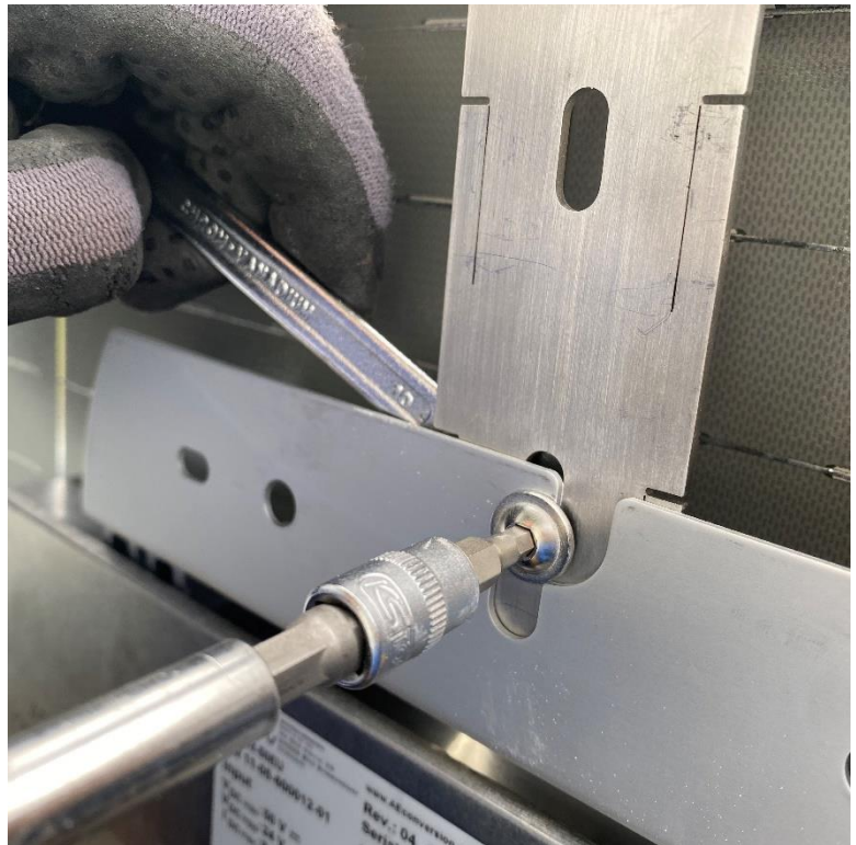
Abb. 6/Wechselrichter am SOLAR-HOOK Befestigungsbügel anschrauben
