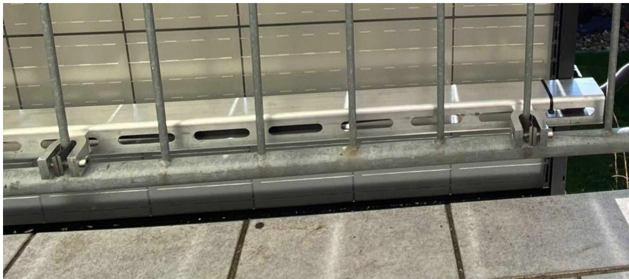
Abb. 10/ Montageschiene an Spezialklemme
