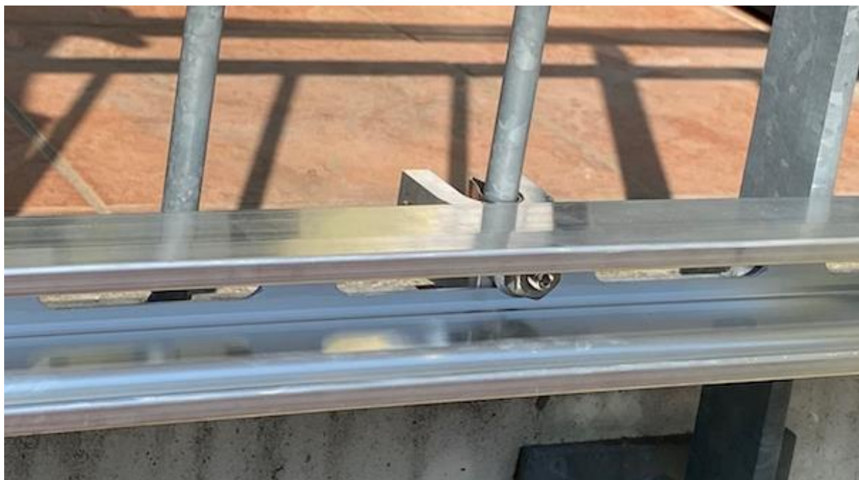
Abb.g 11/Montageschiene und Spezialklemme von außen
