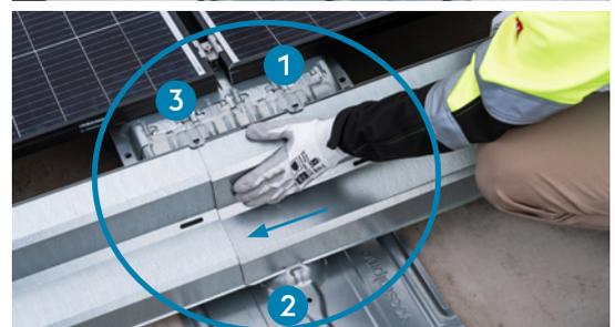
Die iFIX S Deflectoren so verschieben, dass sie am Reihenende 40 bis 60 mm von der Kante des iFIX S Verbinders enden.
